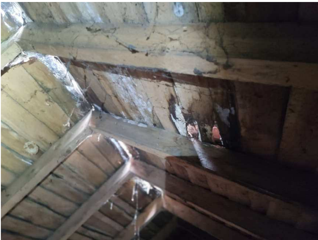
F-12 Pastato stogo konstrukcijos. Gegnės, ištinis lentų paklotas.
