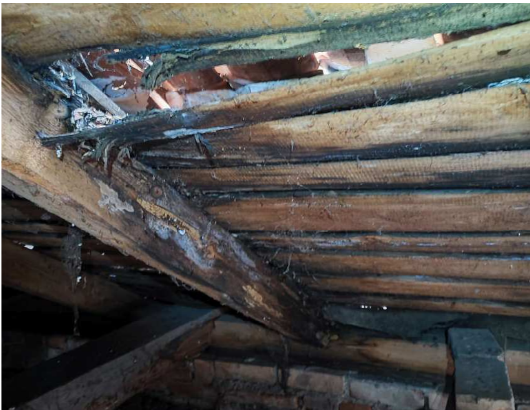
F-6 Pastato stogo laikančios konstrukcijos. Bendras vaizdas. Mūrtašis, gegnė, lentų paklotas.
