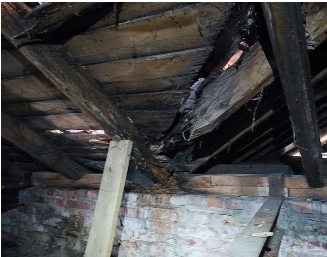
F-8 Pastato stogo konstrukcijos. Valma, gegnės, lentų paklotas.
