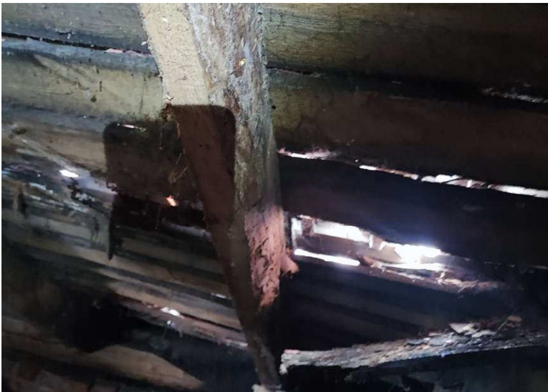
F-11 Pastato stogo konstrukcijos. Gegnė, ištinis lentų paklotas.
