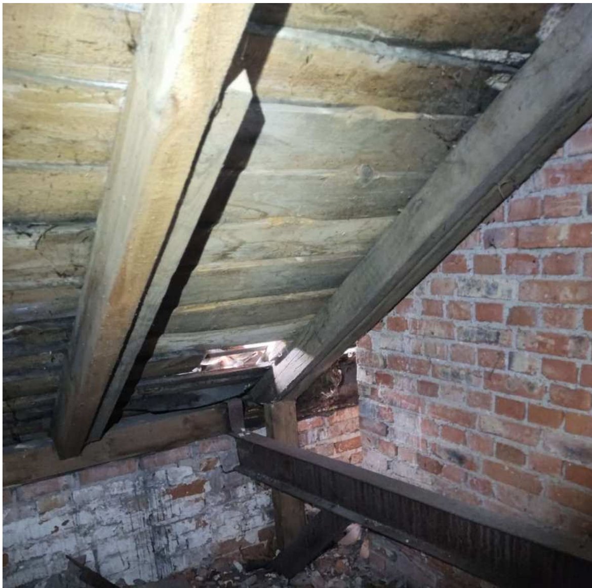
F-15 Katilinės pastato stogo konstrukcijos. Gegnės, iššinis lentų paklotas.
