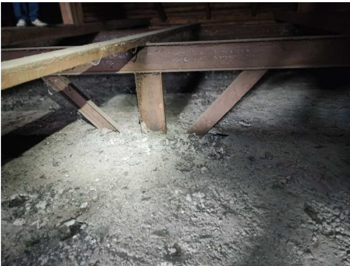
F-14 Katilinės pastato perdangos ir stogo metalinis rėmas. Bendras vaizdas.
