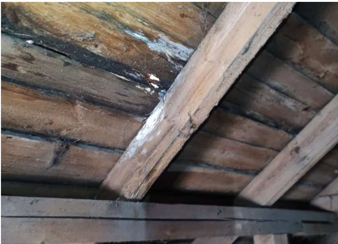
F-9 Pastato stogo konstrukcijos. Rėmo viršutinė sija, gegnės, paklotas.
